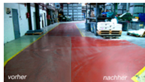
Werkshalle TUNLOP Hanau / auf Beton Belag
